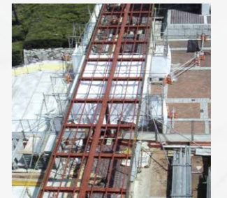
庭廊下改修工事
