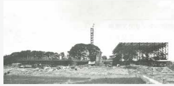
建設中の県民文化センター
