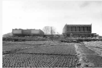
完成した文化センター
